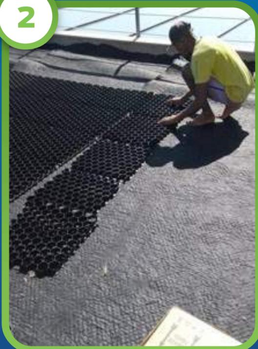
Em cima da manta, os módulos da Estrutura Permeável são encaixados.
