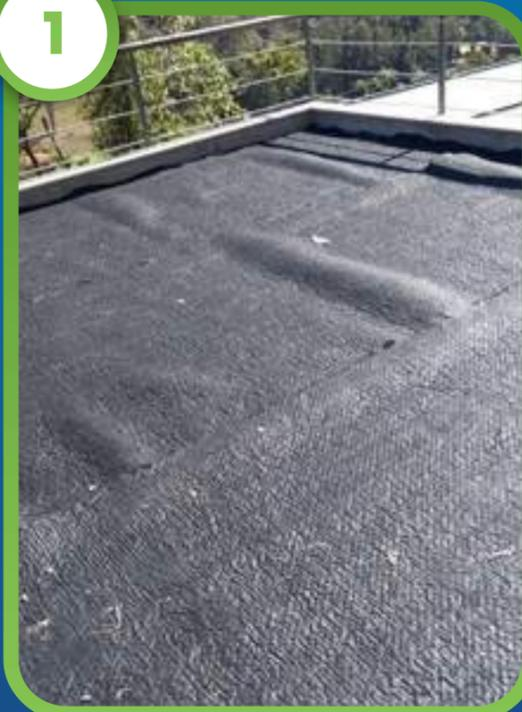
Após a impermeabilização do solo que receberá o telhado verde, é aplicado uma manta drenante.
