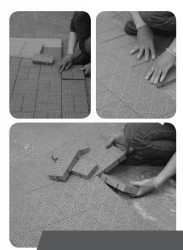
4.5 Depois de montado, utilize uma placa vibro compactadora para que o Paver adentre na camada de assentamento, chegando até a base, de forma que seu interior fique totalmente preenchido.
