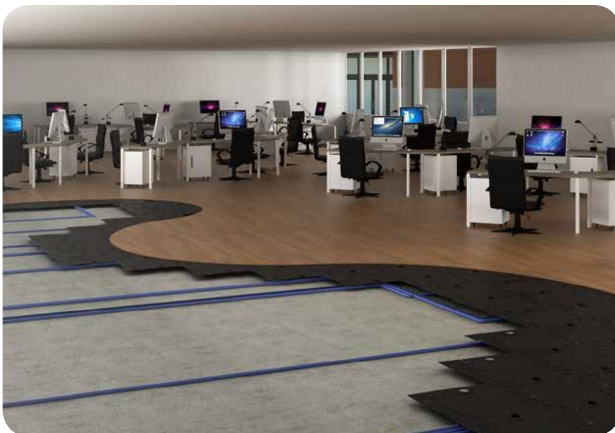
Consiste em cinco componentes principais: Base conectora, piso, lateral com e sem furo e o canto. Na instalação os pisos são unidos pela base conectora, que, automaticamente, ao serem encaixados formam os vãos para a passagem dos cabos.
