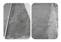
4.3. Coloque uma camada de aproximadamente quatro centímetros de areia para assentamento e sustentação, nivele-a e compacte-a. Depois de compactada, essa camada deverá estar nivelada com a contenção.
