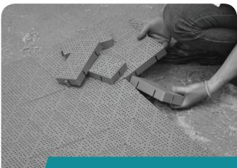
4.5 Depois de montado, utilize uma placa vibro compactadora para que o Paver adentre na camada de assentamento, chegando até a base, de forma que seu interior fique totalmente preenchido.
