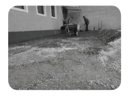
4.2. Prepare o solo, nivelando a terra. Para passagens de veículos, o solo existente deverá apresentar resistência para esse tipo de aplicação. Se necessário, reforce o solo com pedra.
