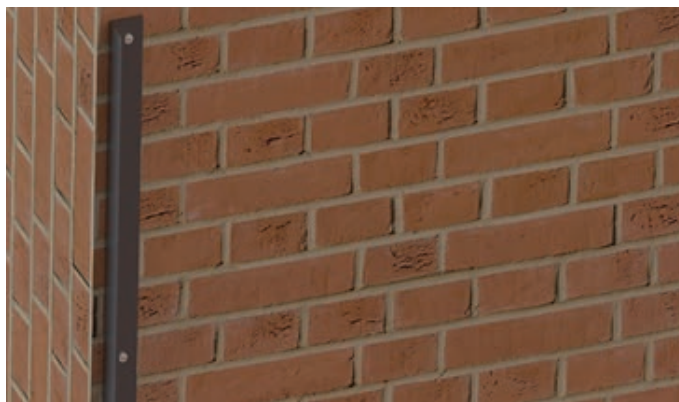
Instalação da cantoneira que será posicionada abaixo e ao lado da peça recortada.
