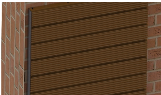
Detalhe da montagem do produto com a utilização de uma cantoneira à esquerda.
