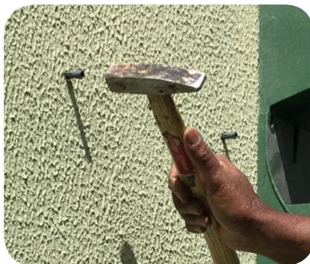
**5º Passo:** Coloque o Módulo para Jardim Vertical novamente na parede e fixe-o com os parafusos.
