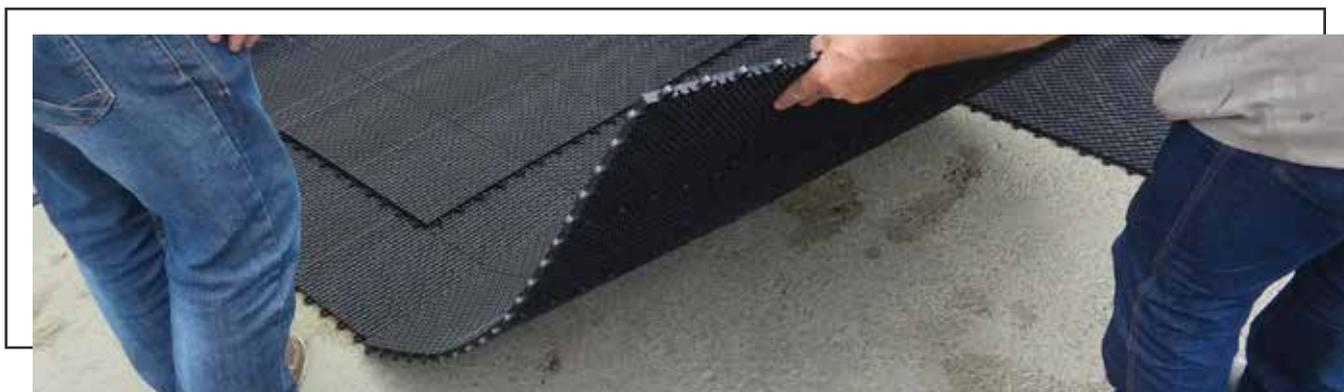
3) As placas de piso devem ser encaixadas entre si através do sistema de cliques laterais macho e fêmea, situados nas extremidades, como na imagem abaixo:
