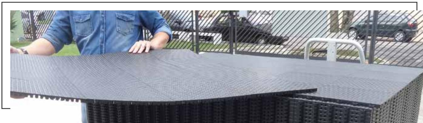
2) Primeiramente, certifique-se de que a base esteja nivelada e possua resistência mecânica suficiente para a aplicação desejada. Indica-se o uso de piso de cimento como base sob o Piso Modular Esportivo.
