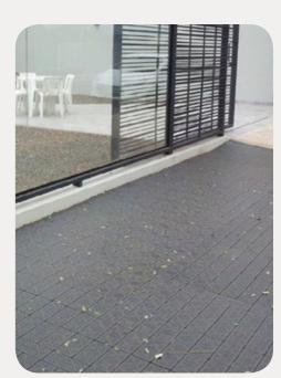
Uma solução sustentável ao paver comum, este paver plástico conta com pequenos furos na superfície, possibilitando o escoamento de água, garantindo a permeabilidade do solo.
